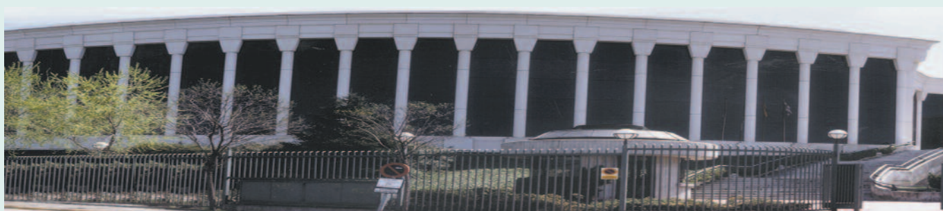
Edificio de Oficinas alquilado al Grupo Dragados. San Sebastián de los Reyes, Madrid
