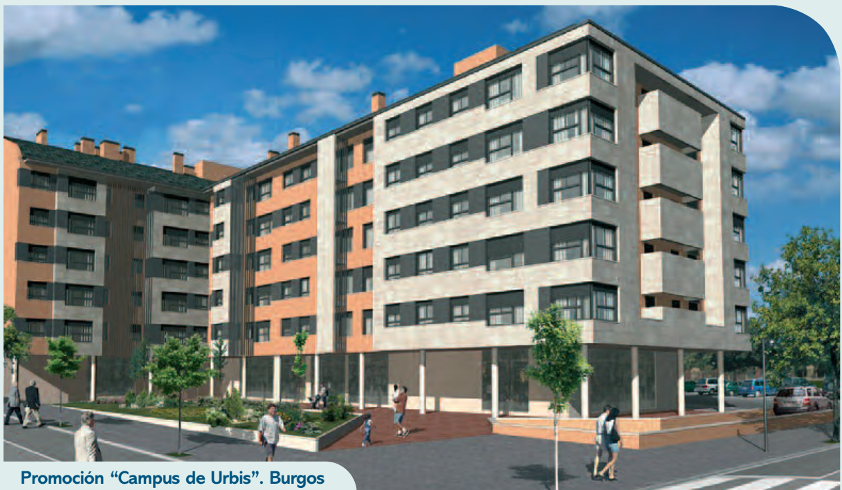
Edificio Sanz Pastor. Burgos
