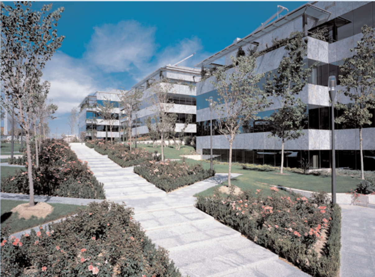
Zona interior “Urbis Center”. Pozuelo. Madrid.
