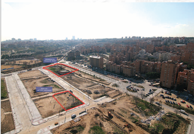
Solares Antonio Machado y Valle de Mena, Madrid
